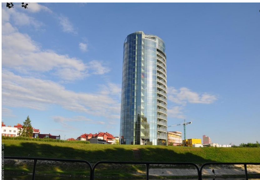
Fotografia 2. Przykładowe osiedle prestiżowe w Rzeszowie – al. Kopisto
